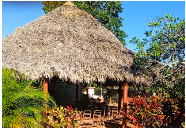
Instalación rústica para actividades y extensión.
